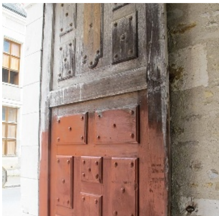
Les portes reprennent des couleurs. Deux couches de peinture à l'ocre sont nécessaires afin de rendre le bois imputrescible et de le protéger des effets des rayons ultraviolets.
